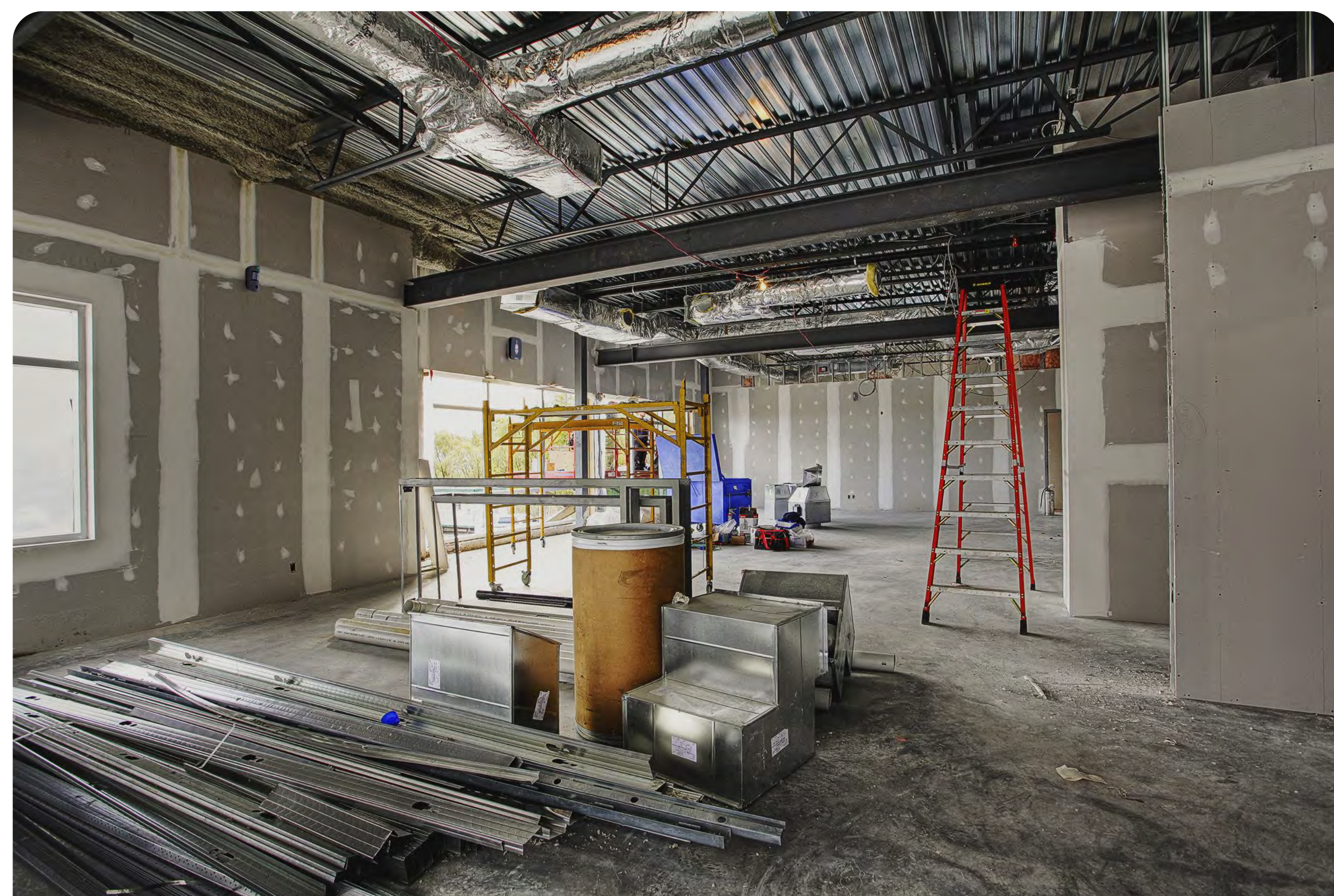
Construcción activa o congelada con materiales y equipamiento de alto coste en el interior
